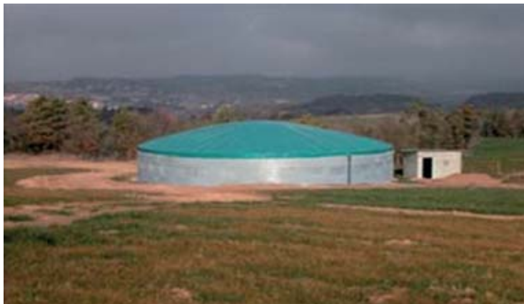
Figura 5.- Depósito de purín con cubierta fija.
